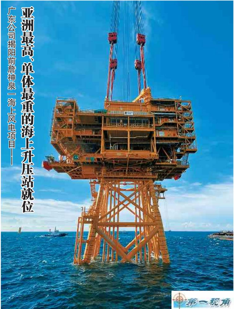
▲5月27日16点18分,位于广东省惠来县神泉海域的揭阳前詹神泉一海上风电项目海上升压站上部组块安装,标志着重约2800吨的亚洲最高、单体最重的海上升压站就位。该项目升压站上部组块是连接海上风力发电机组与陆上集控中心的重要“纽带”,起到将海上风机所发电能汇集、升压通过陆上集控中心输送至电网的关键作用。方荣滨 摄
